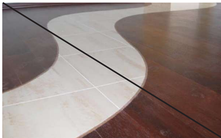
Плохо Узорные стыки из разных материалов
